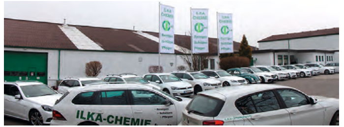
Firmenzentrale in Öhringen mit ca 7000m 2 Gesamtfläche
