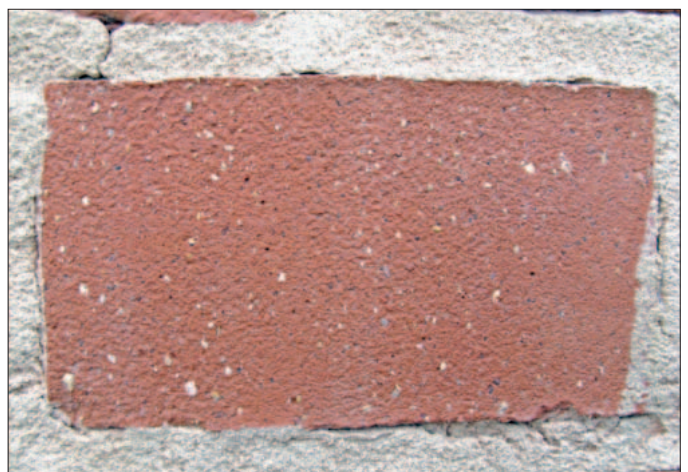
Abb. unten rechts: Gestrahlter Klinker: Die Oberfläche ist zerstört und für Verwitterungsvorgänge geöffnet.
