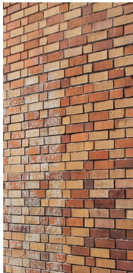
Mit **ILKA-Rapid AP** und **ILKA-Steinreiniger S** teilgereinigte Klinkerfassade des Planetariums. Links ist die alte Graffitischutzschicht zu sehen.
